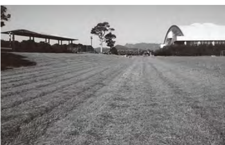
▲整備中の妙田グラウンド
