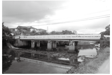
▲完成から80年余り経過した友内橋(無鹿町)
