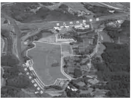
▲クレアパーク延岡工業団地
