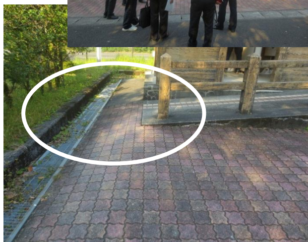
北川運動公園トイレ 北側
