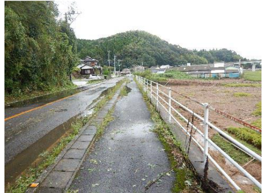
図 13 小峰地区、行藤川堤内痕跡状況 (9 月 19 日 09:40 頃)
