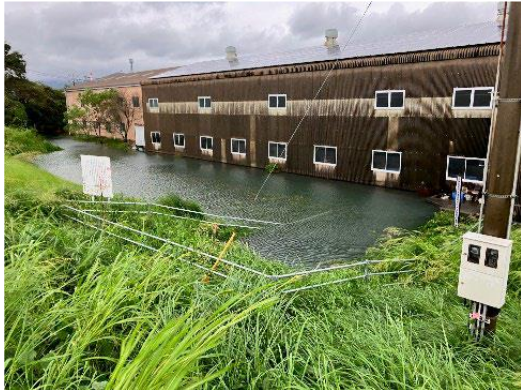
図 12 川原崎地区、祝子川右岸 1k200 付近堤内 (9 月 19 日 08:00 頃)
