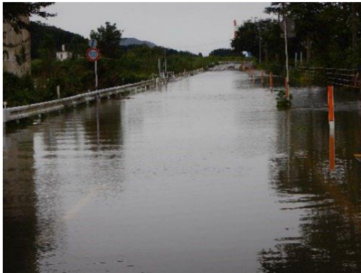
図 14 三輪地区、五ヶ瀬川右岸 9k200 付近堤内 (9 月 19 日 09:10 頃)
