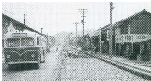
萩町の道路舗装工事(昭和32年//延岡市役所)
