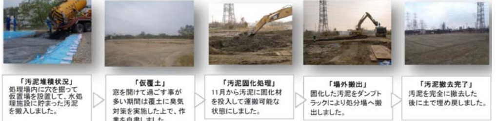
汚泥搬去場の設置事例(宮城県南浄化センター) 出典:「災害時における下水の排除・処理に関する考え方(案) 平成24年9月 国土交通省国土技術政策総合研究所 57ページ」より
