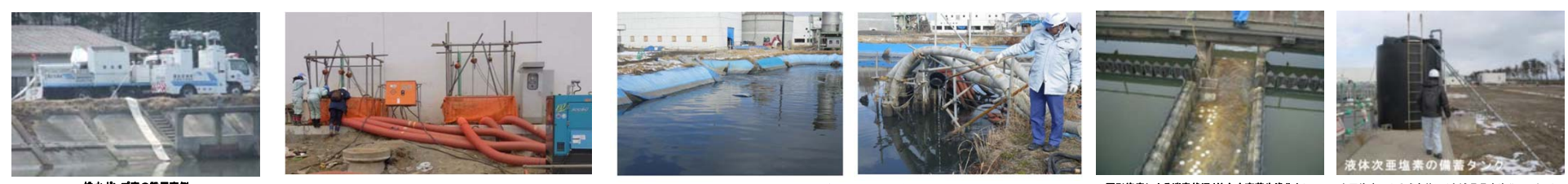
排水ポンプ車の設置事例 (出典:「下水道BPC策定マニュアル 第2版(地震・津波編) 平成24年3月 国土交通省水管理・国土保全局下水道部100ページ」より) 仮設ポンプの設置事例(宮城県石巻東部浄化センター) 仮設沈殿池の設置事例(宮城県南浄化センター) 固形塩素による消毒状況(仙台市南浄化センター) 次亜塩素による消毒状況(宮城県南浄化センター) 液体次亜塩素の備蓄タンク
