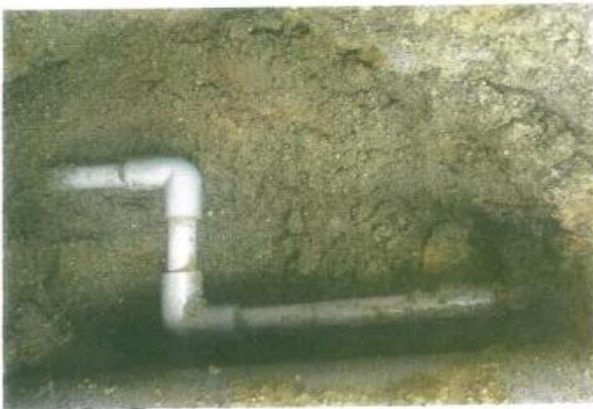
漏水箇所・埋設給水管
