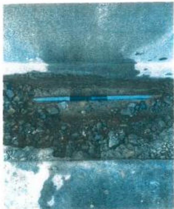
④ <給水管漏水箇所交換作業後>
