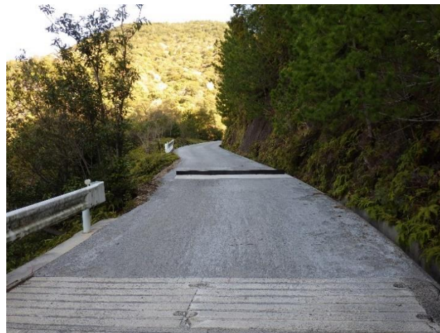
工事状況 (鉄鋼スラグ路盤工、コンクリート路面工、木製横断工)
