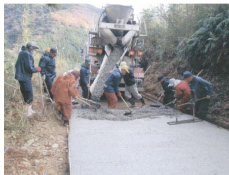
施工状況（コンクリート舗装）
