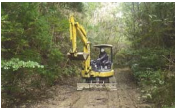
補修作業(崩土撤去中)
