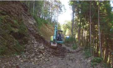
補修作業(木製横断工設置中)
