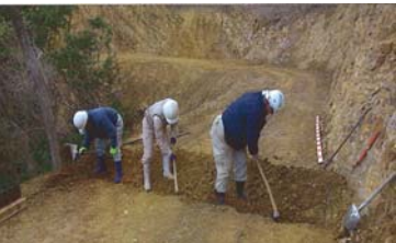
(木製横断工設完了)
