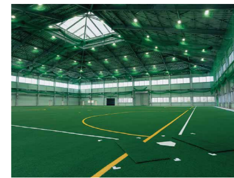
アリーナ 天井面 ※天井部のLED照明は用途に合わせ、全灯、1/2、1/4で使用可能
