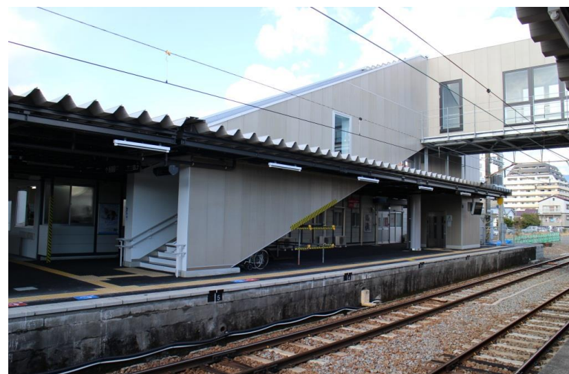
跨線橋(ホームから)
