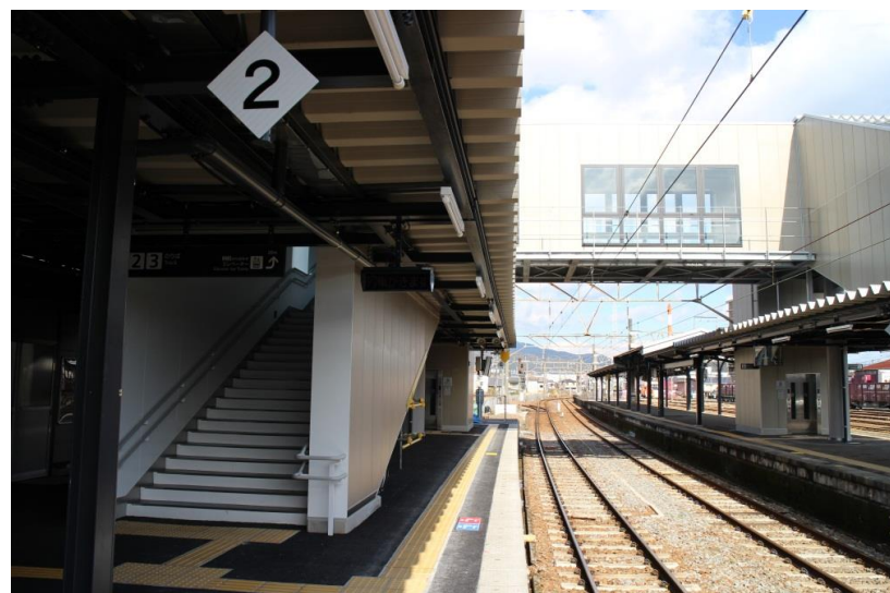
跨線橋(ホームから)
