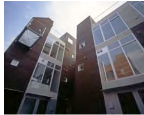
KEELS 集合住宅 2008 RC造・地下1階地上3階
